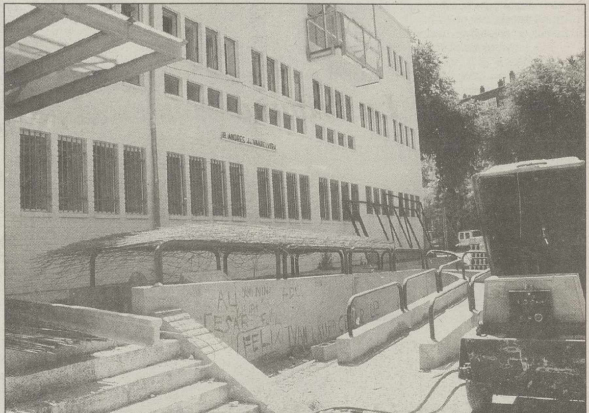
La empresa que realiza las obras de reparación del Andrés de Vandelvira trabaja a un ritmo rápido.
