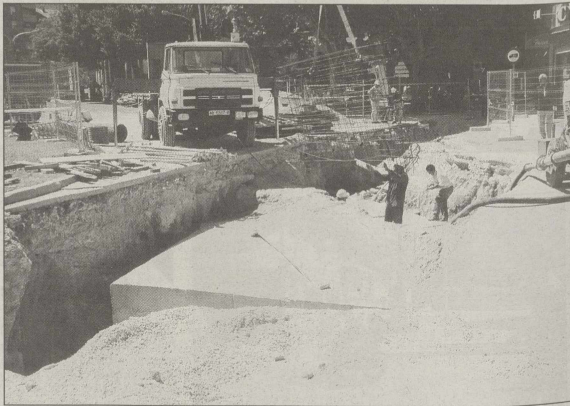
Las obras del colector de la zona centro van a buen ritmo, según el concejal de Urbanismo.
