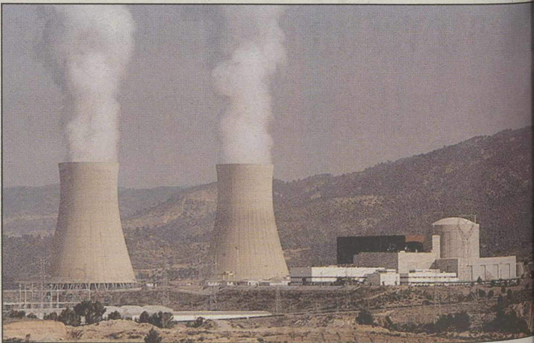
La planta atómica de Cofrentes durante el segundo semestre de 1997 ha producido 3.190,3 millones de kWh.
