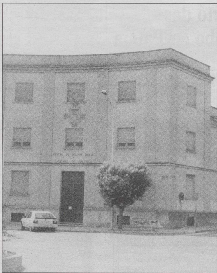
CC.OO. y UGT pueden utilizar la antigua Casa de Socorro.
