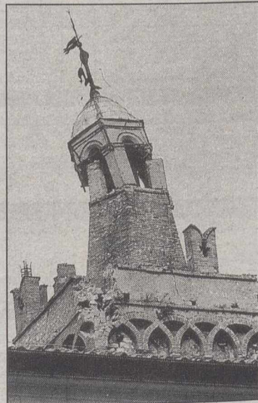
El terremoto causó daños.
