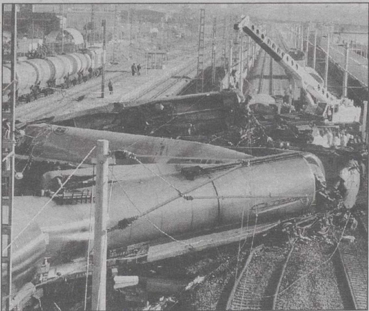
Los vagones descarrilados derramaron gran cantidad de gasoil.
