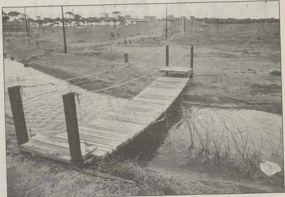
La falta de vigilancia está contribuyendo a que el parque sufra daños en sus instalaciones.
