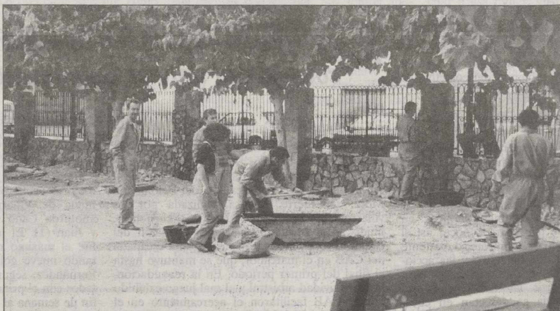
Alumnos de la Casa de Oficios trabajando en el Recinto Ferial.
