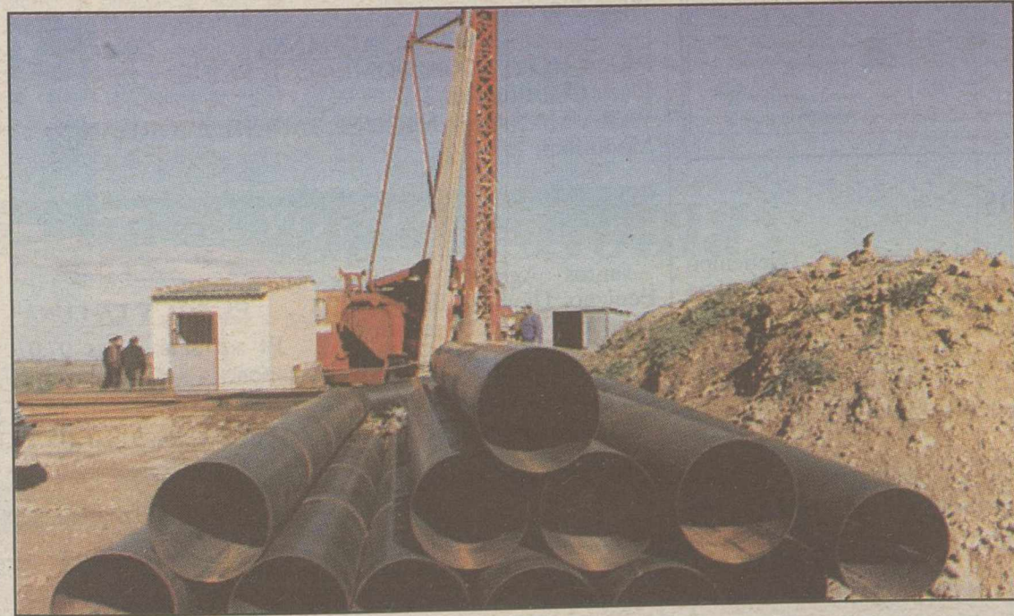
Ayer se notificaron sanciones millonarias por simples trabajos de mantenimiento de pozos en Albacete.
