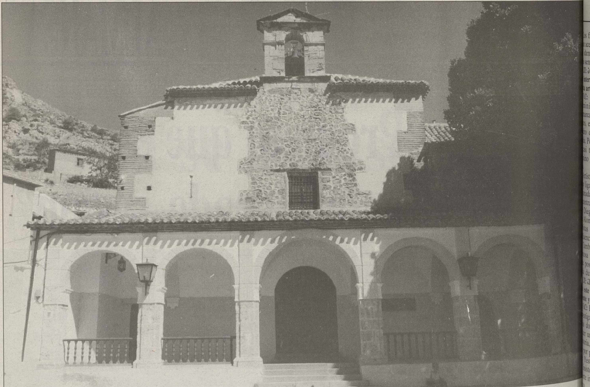
Fachada del convento alcantarino de San Francisco de Yeste.
