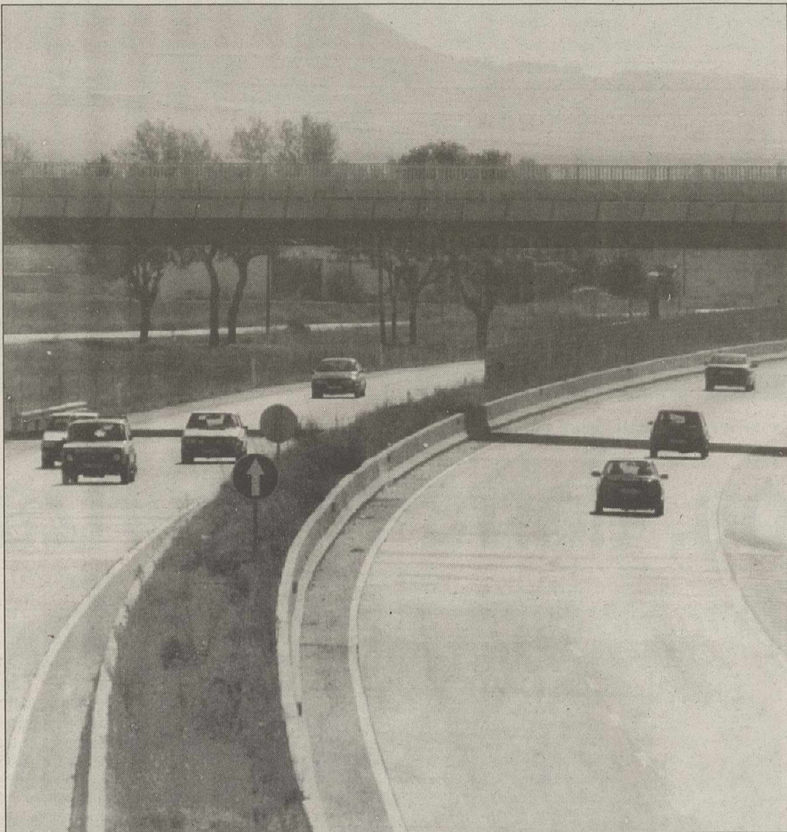
La ausencia de accidentes mortales y la existencia de tráfico denso pero fluido, notas de este "puente" en Albacete.
