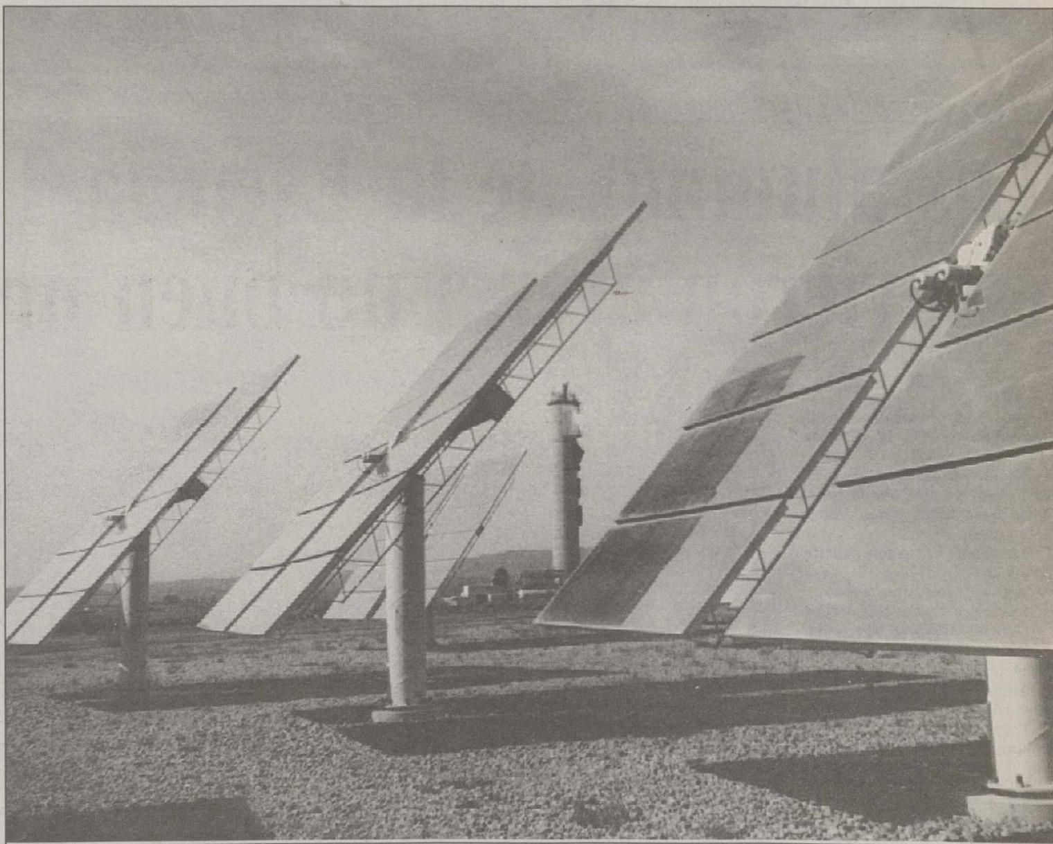
Los módulos fotovoltaicos son los encargados de transformar la energía luminosa en corriente eléctrica continua.
