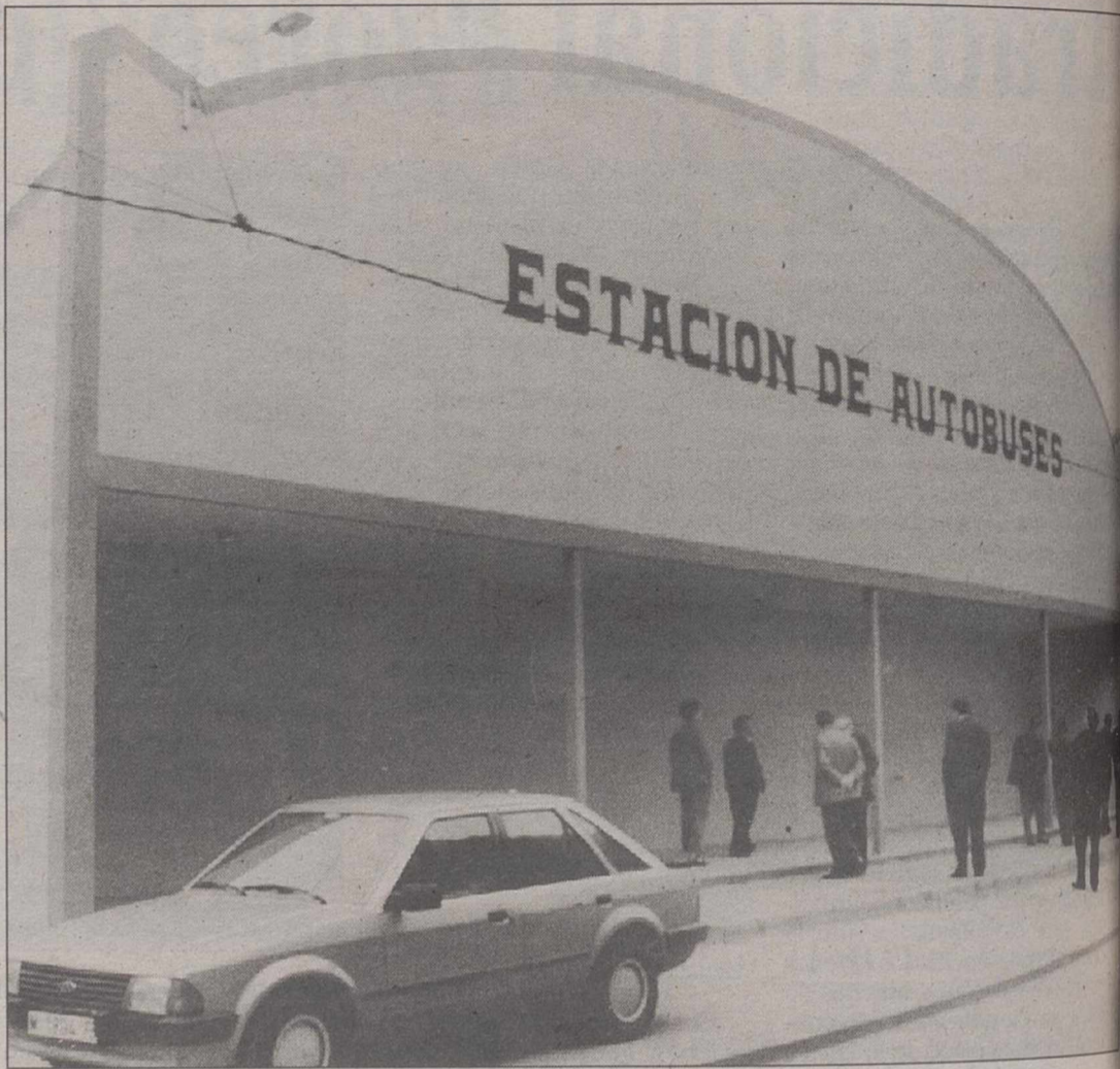
Cruz Roja y Protección Civil ya están instalados en las dependencias de la Estación de Autobuses.
