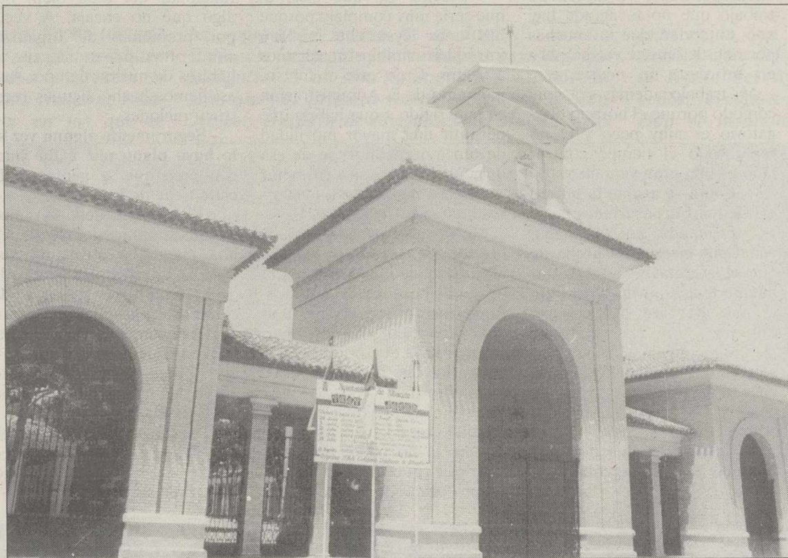
En el Recinto Ferial se renovarán cubiertas y muros.
