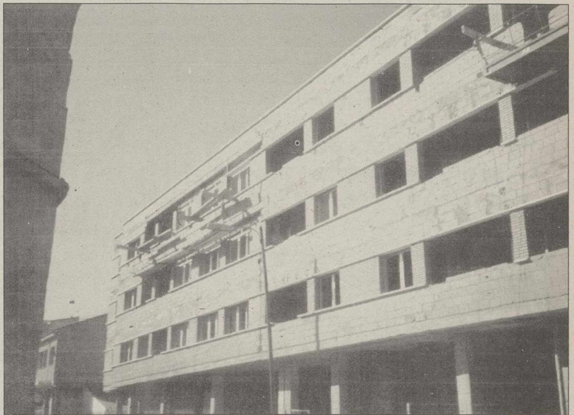
La constructora ha recibido más del doble de lo que equivale a obra ejecutada.
