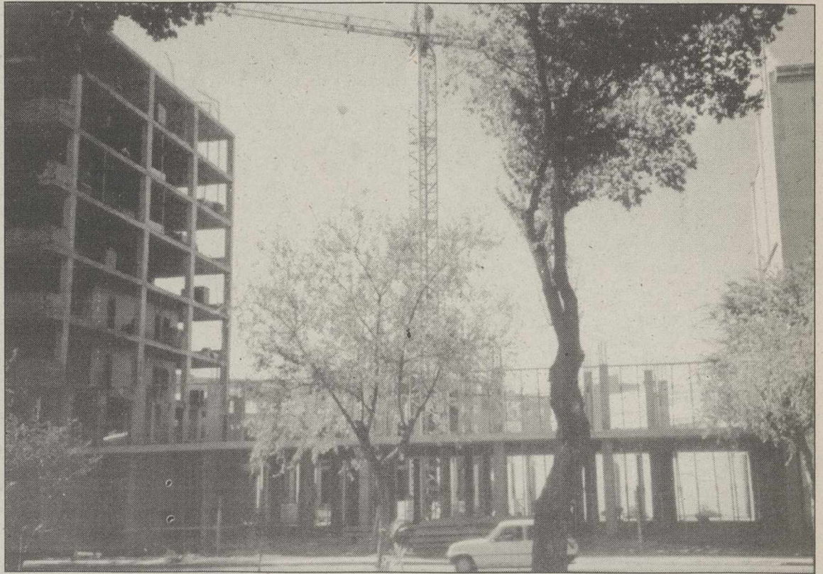
Estado de la construcción cuando la promotora abandonó las obras.
