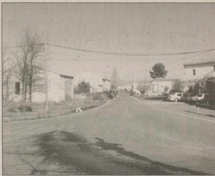
El Ayto. de Tobarra aprobó también el alcantarillado de la pedanía.
