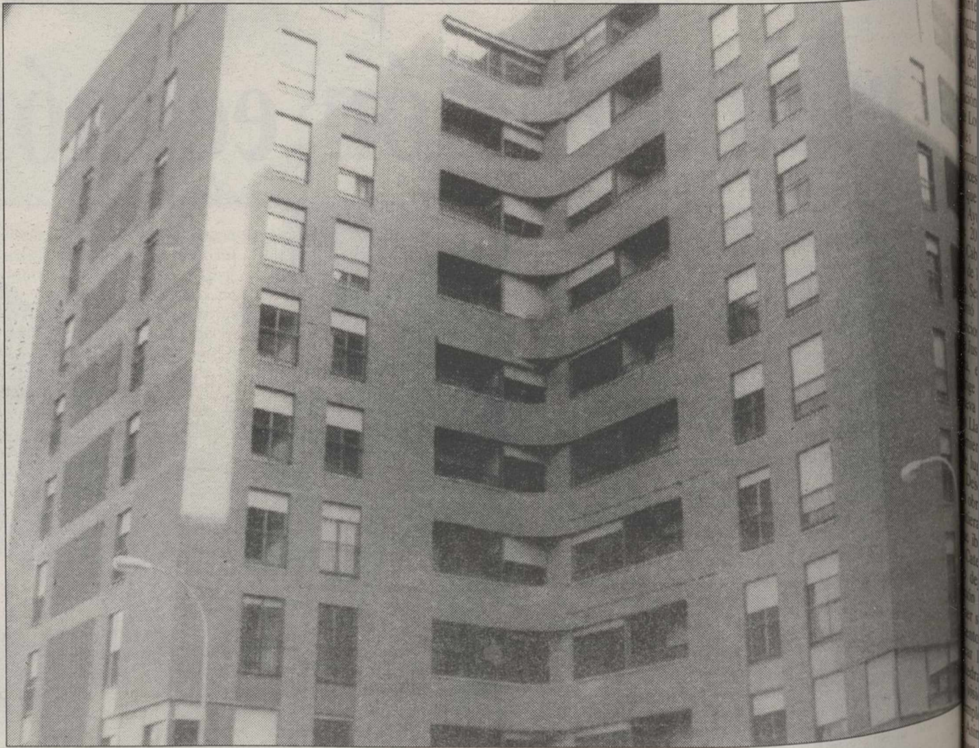
La sentencia reconoce los graves "daños morales" sufridos por los vecinos del Edificio Chinchilla por los defectos en la construcción.
