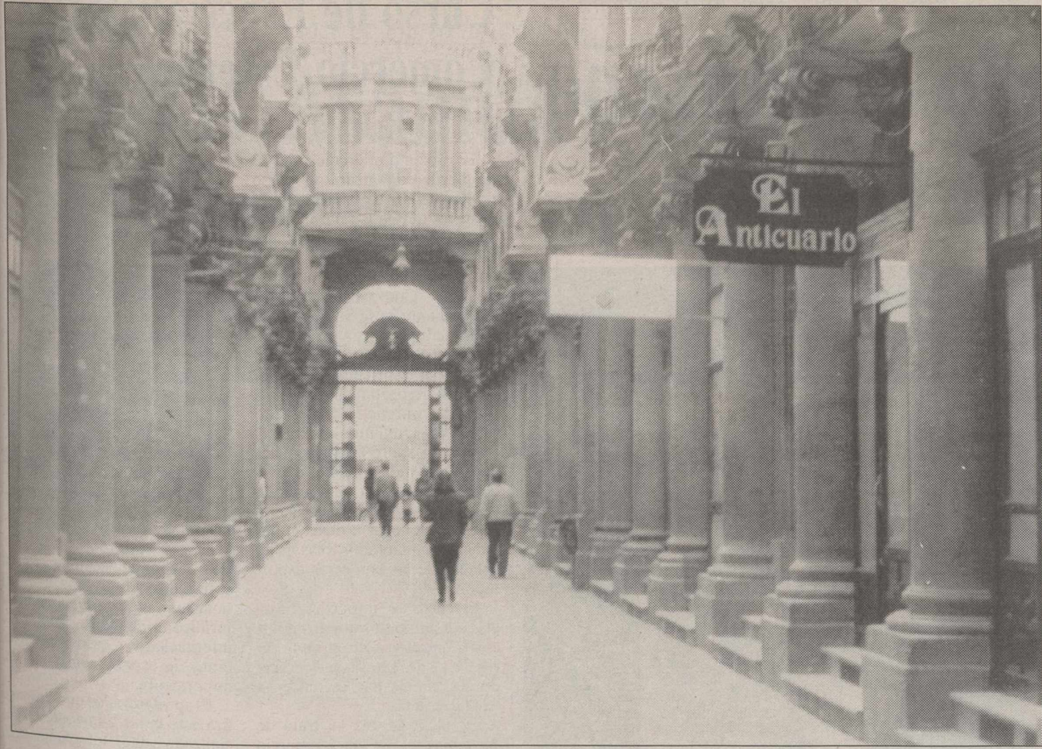
La Comisión de Patrimonio estudió ayer una denuncia sobre la colocación de carteles comerciales en el Pasaje de Lodares.
