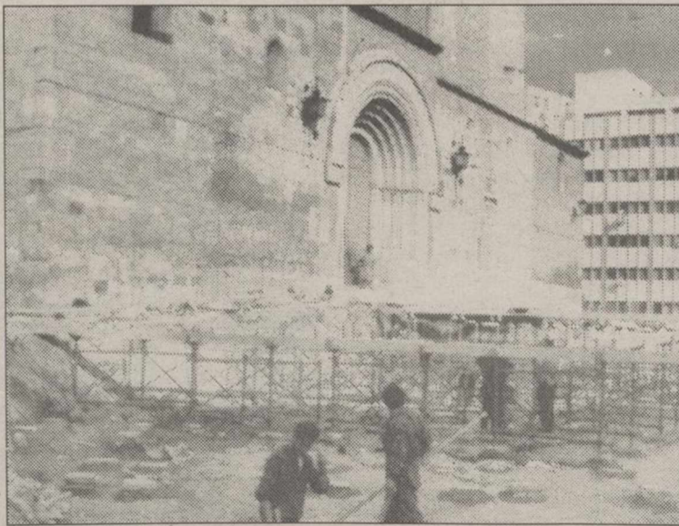
El Edificio Toscana se encuentra a las espaldas de la Catedral.
