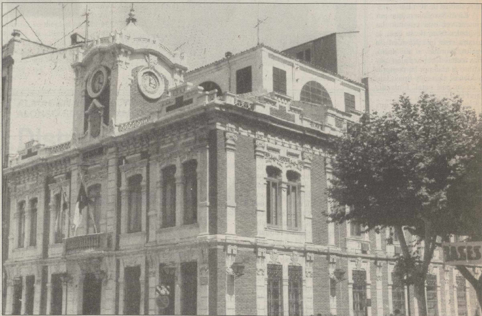
Una vez terminadas las obras, el edificio deberá dejar de ser el viejo Ayuntamiento.
