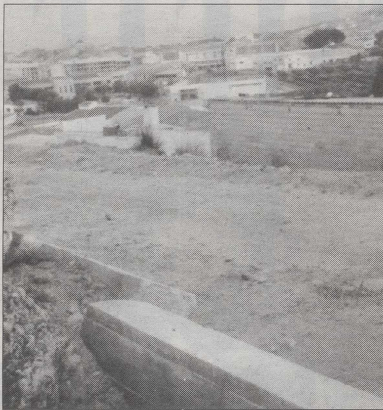
Muro de contención del Barrio del Pino en Hellín.
