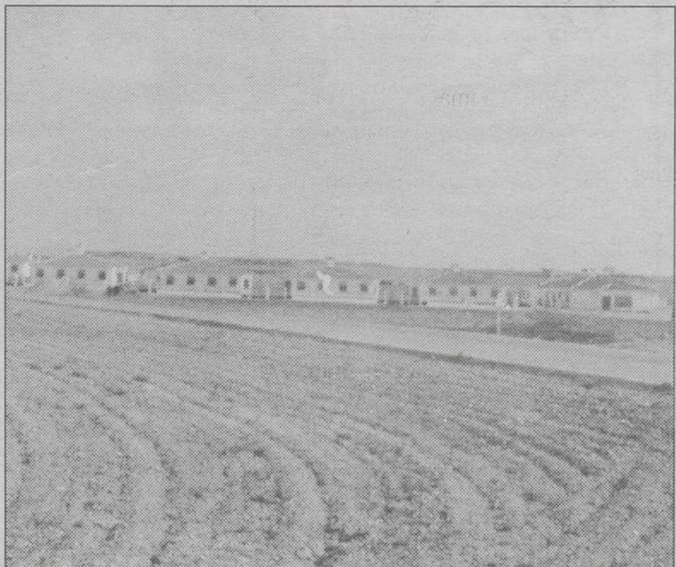
16 viviendas de carácter oficial construidas en Motilleja.
