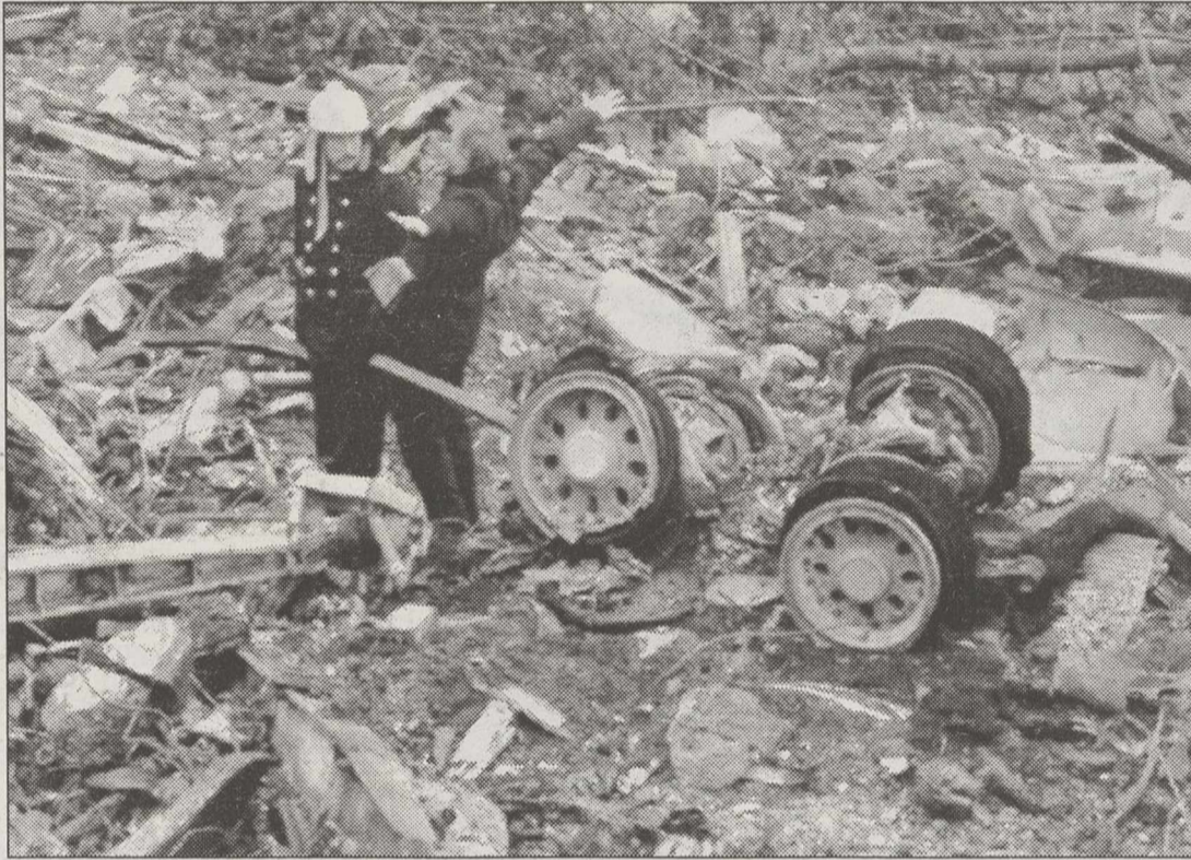
La mayor parte de los cadáveres debe estar sepultada entre una montaña de cuatro metros de escombros.
