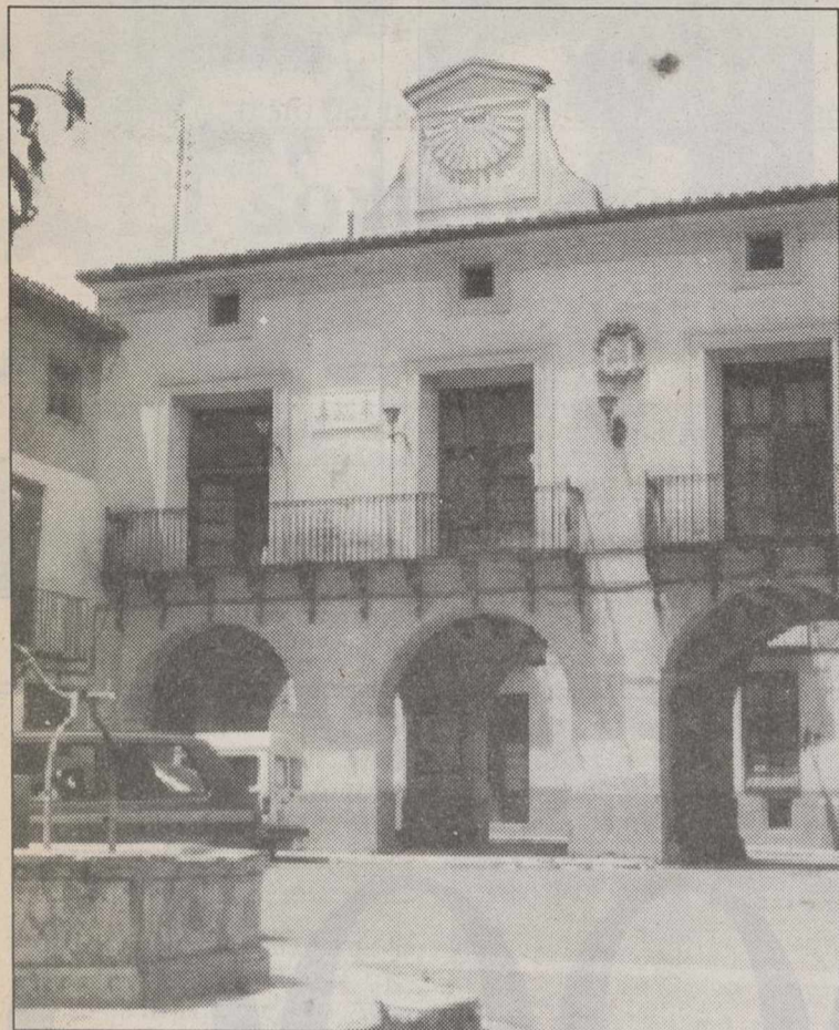
Obras en Caudete.
