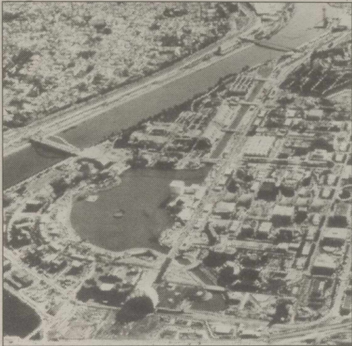
Vista panorámica de las obras en la Expo'92.
