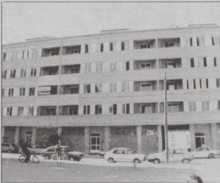
El sindicato trata de encontrar soluciones eficaces al problema de la vivienda.
