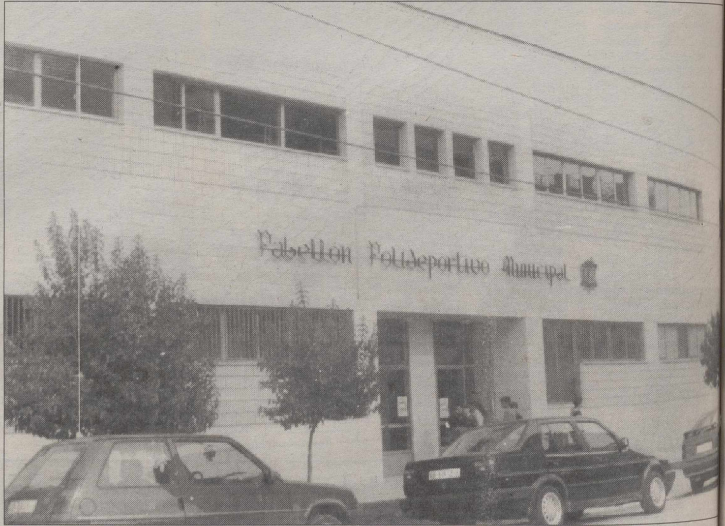
Pabellón Polideportivo de Hellín.
