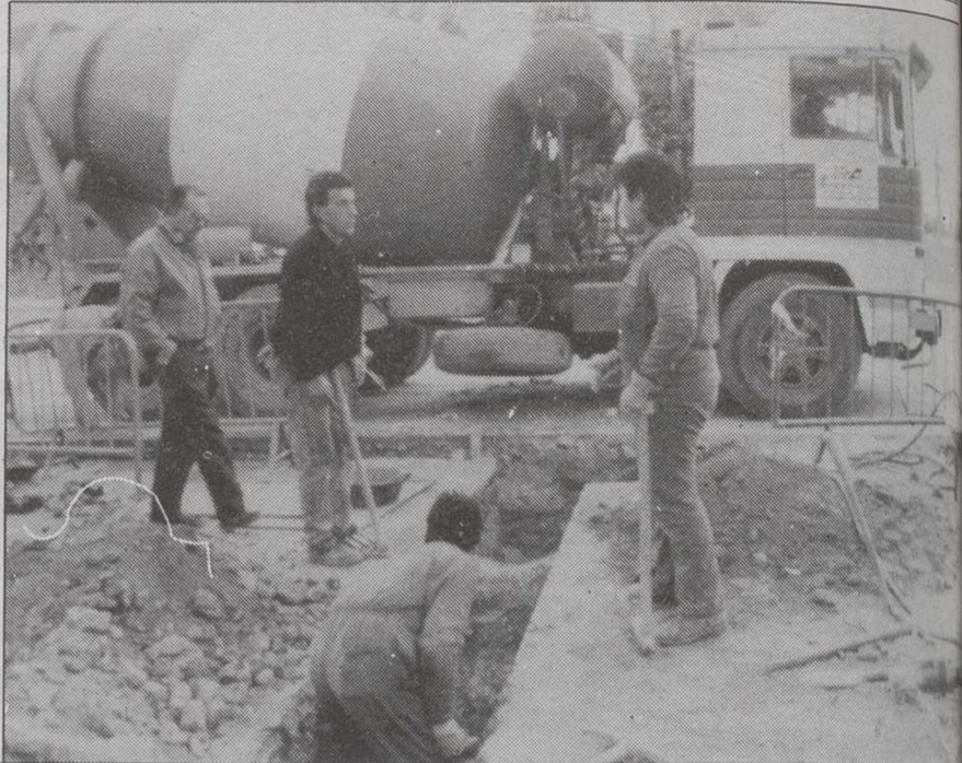
Las zanjas han atravesado el Paseo de la Cuba hasta la calle Alcalde Conangla.
