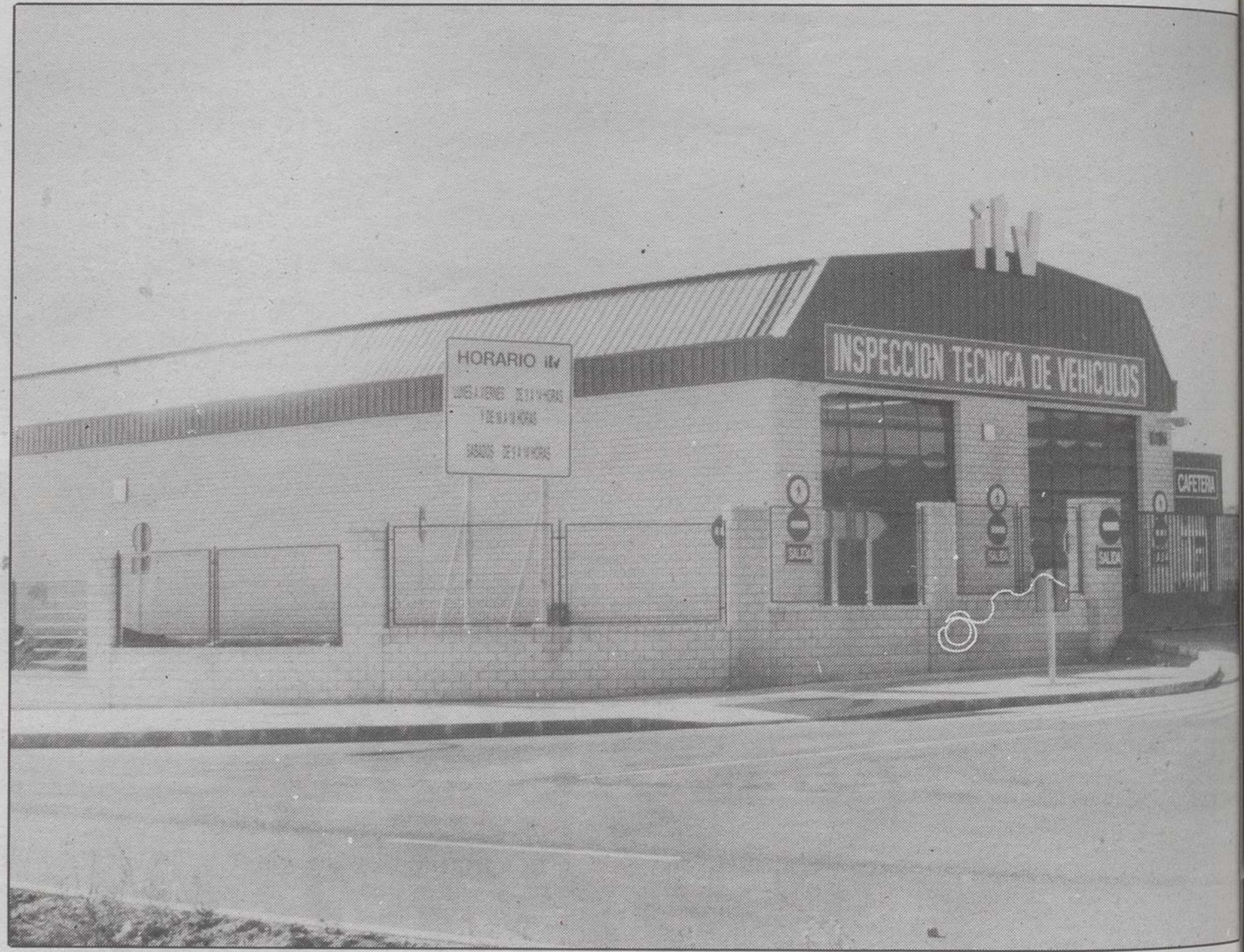
Estación de Hellín de ITV.
