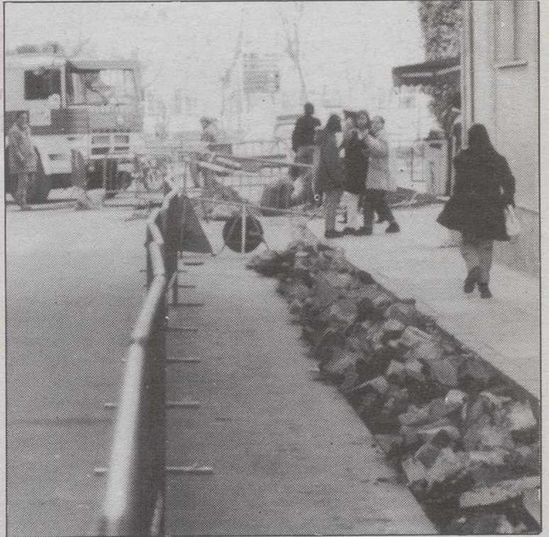
En la calle Salamanca también se relizan las obras de canalización. J. MORENO
