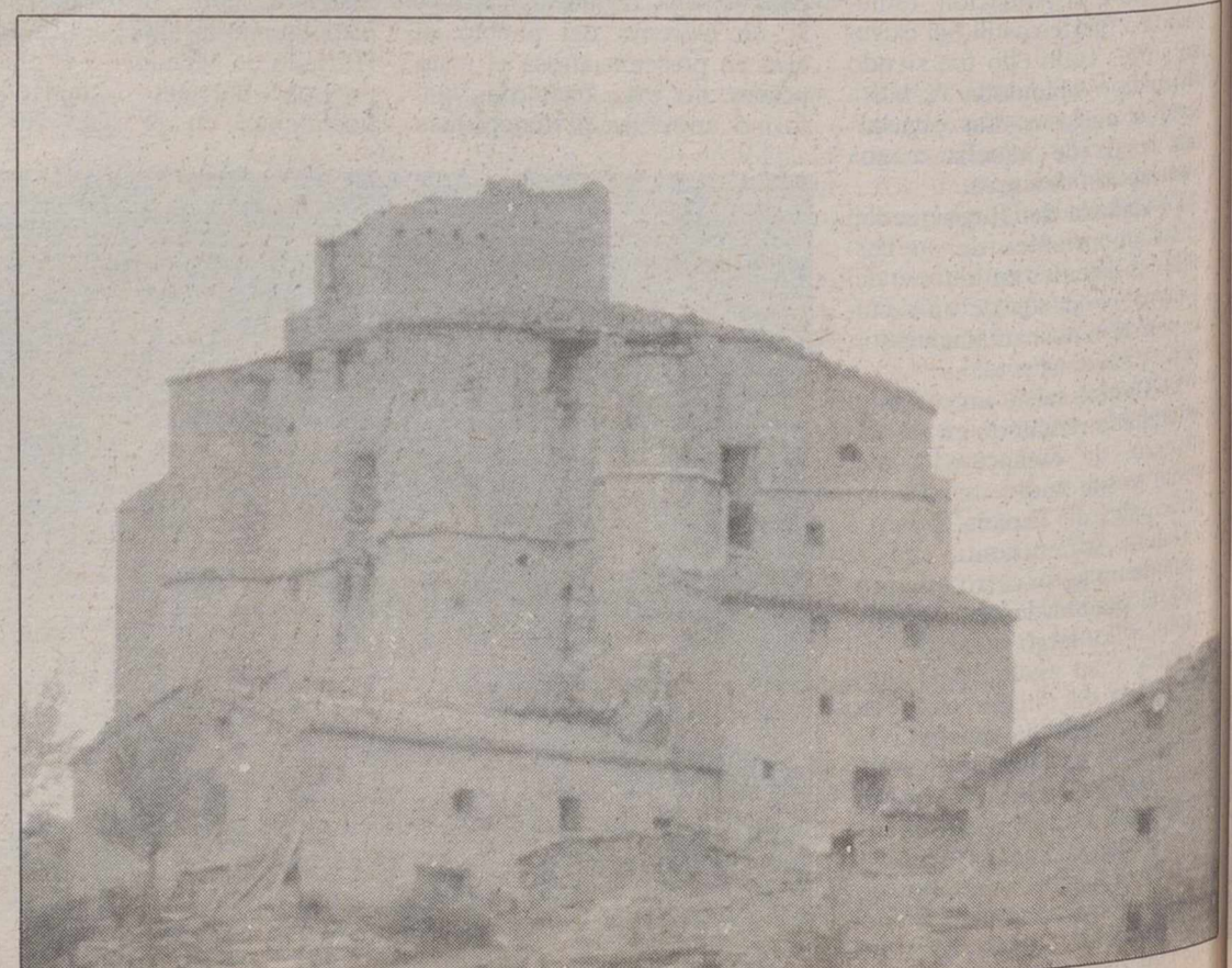
En Salvacañete se encuentra el espléndido castillo de Torre fuerte.
