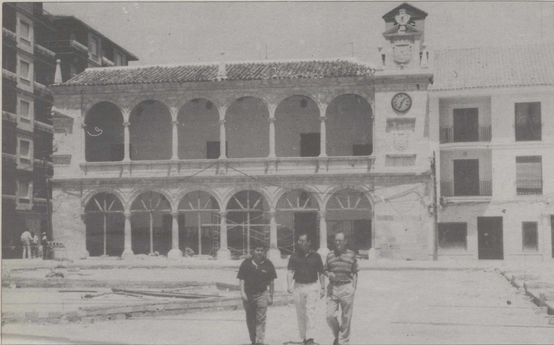
Las obras de la fachada del Ayuntamiento de Villarrobledo ya se han terminado y están finalizando las de la Plaza Ramón y Cajal.
