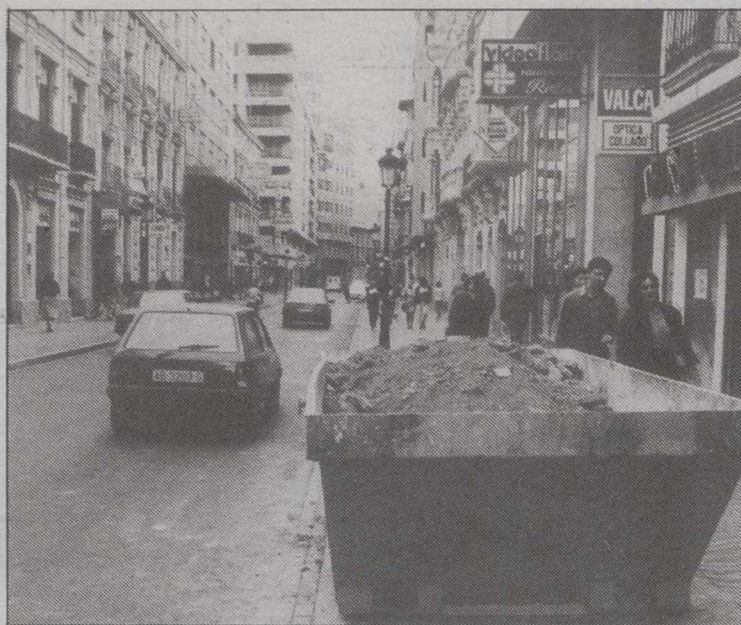
El futuro de las obras de la calle Ancha siguen siendo una incógnita.
