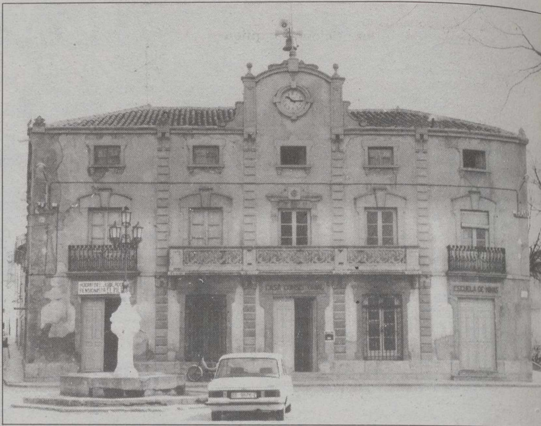
Fachada del Ayuntamiento de Fuentealbilla que se está reconstruyendo.
