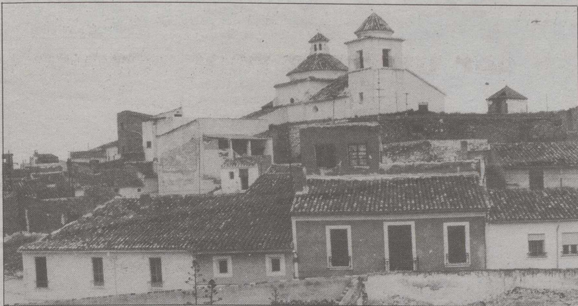
Vista general de la Iglesia de San Roque de Hellín.
