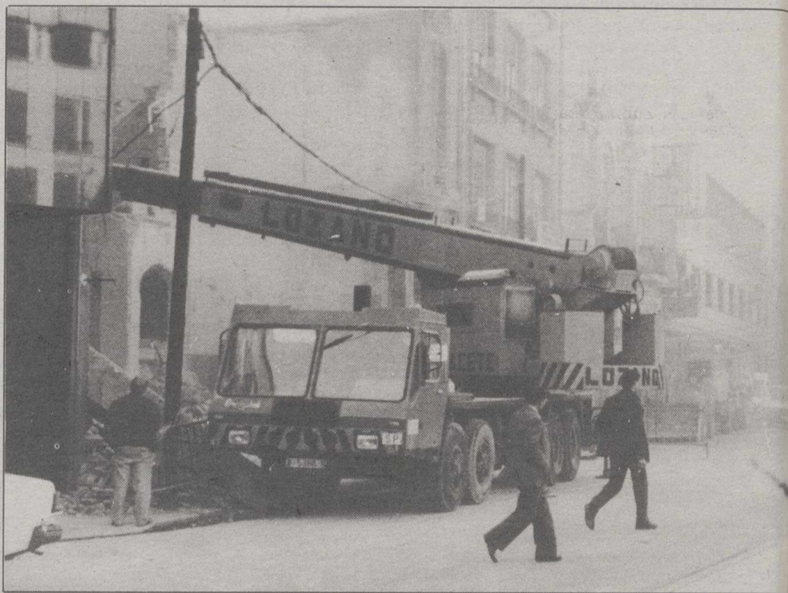
Una poderosa grúa demolió el edificio de la Cámara de Comercio.
