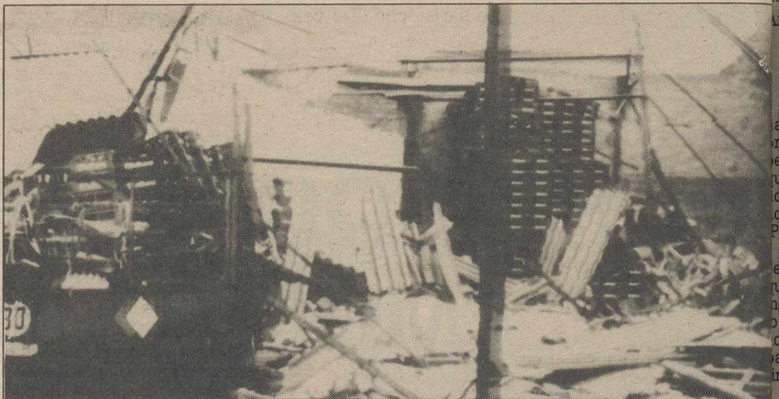
Graves destrozos en las inundaciones de Alcázar de San Juan.
