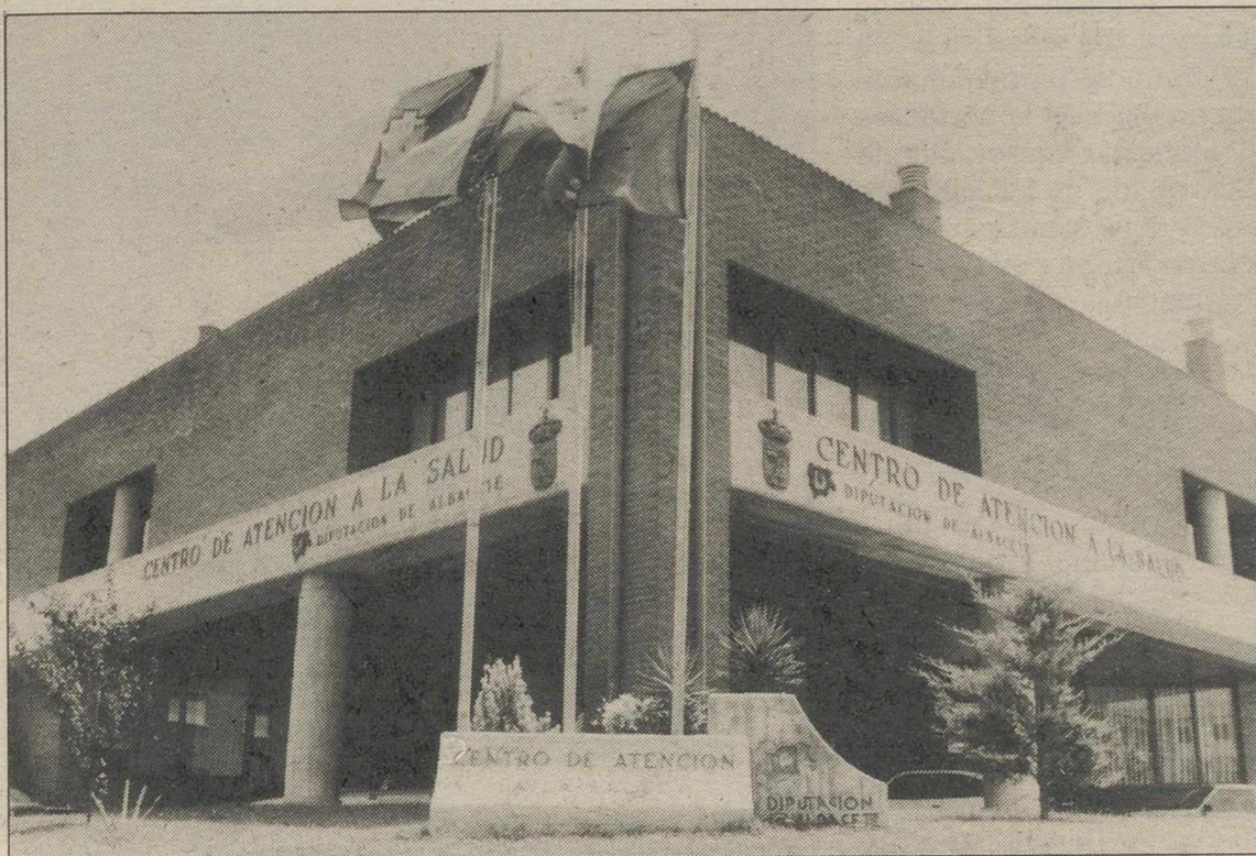
El Centro de Salud de la Zona Uno tiene problemas de personal facultativo.
