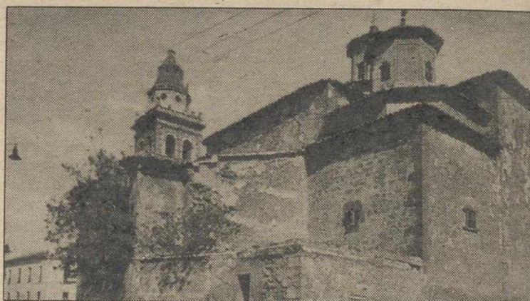
Vista parcial de Casas Ibáñez.
