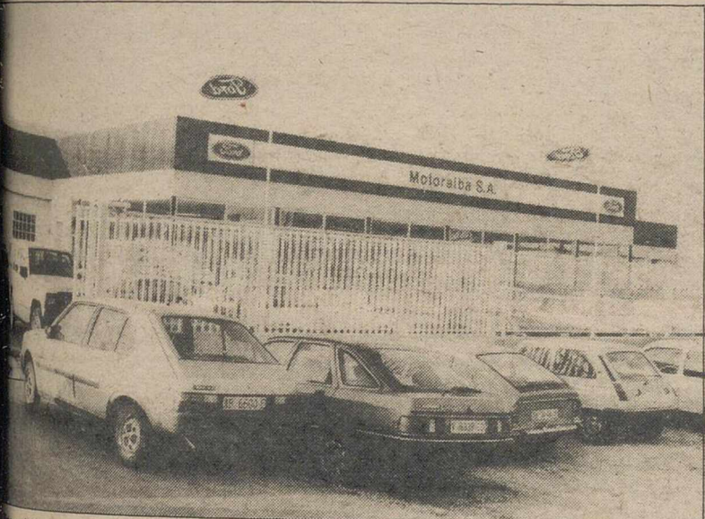
Detalle de la fachada de las nuevas instalaciones.
