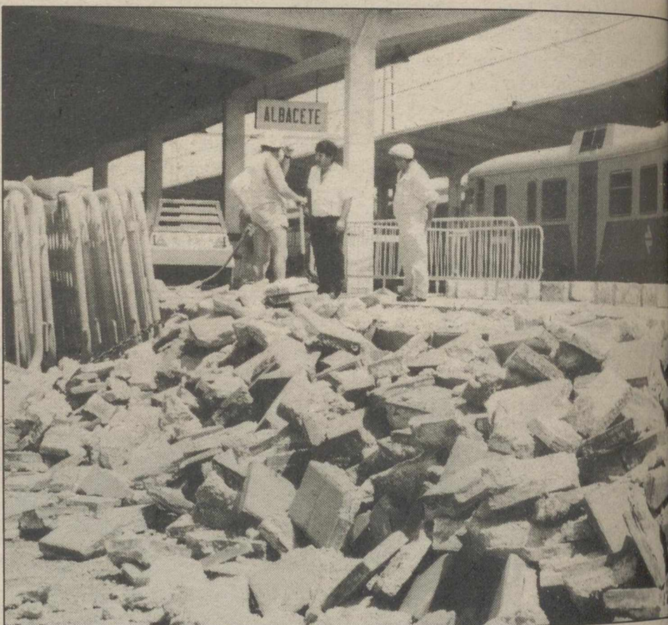
La Estación de Renfe de Albacete será remodelada en profundidad en el plazo de seis meses.
