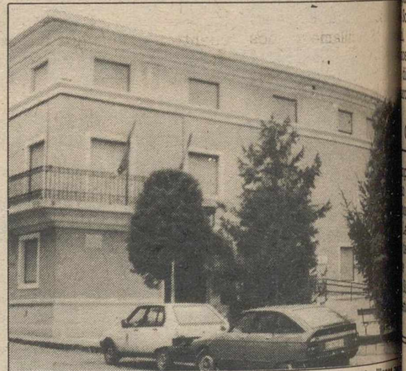
El Ayuntamiento rodense ha elaborado un proyecto de 2.300 millones para remodelar la red de alcantarillado.
