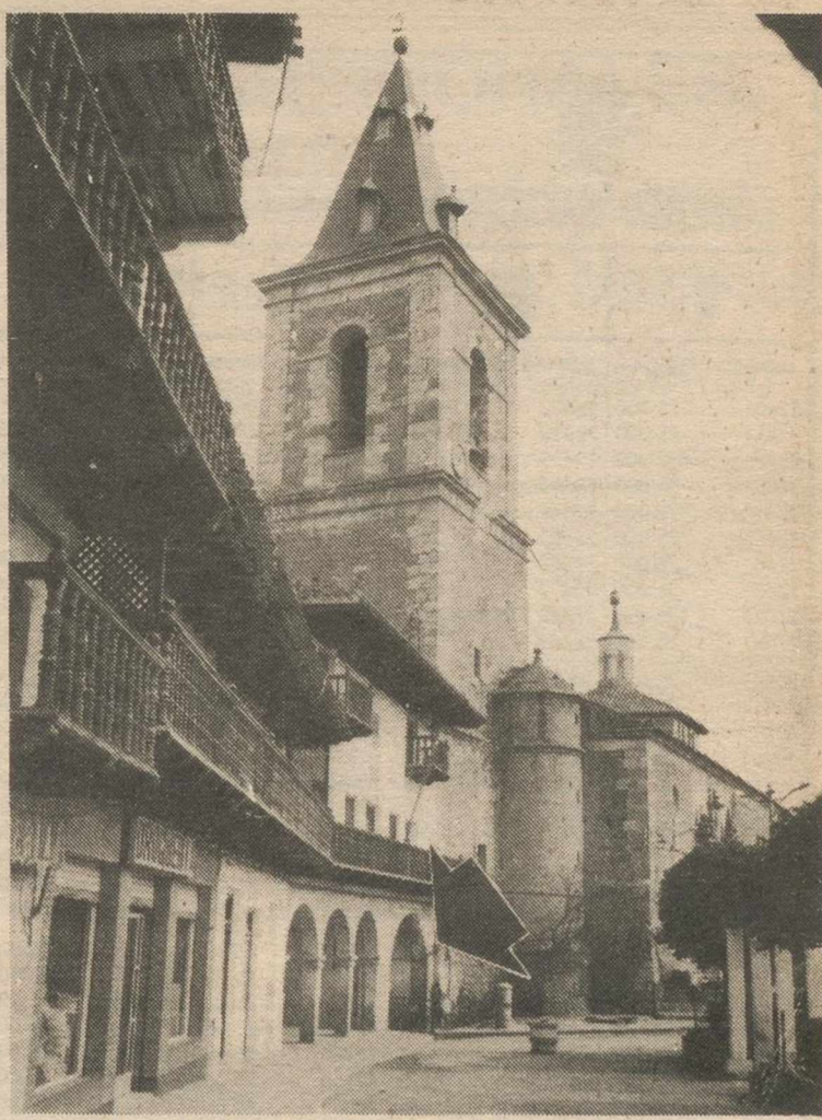
La flecha indica el arco que fue destruido por un camión, originando graves daños en la plaza.
