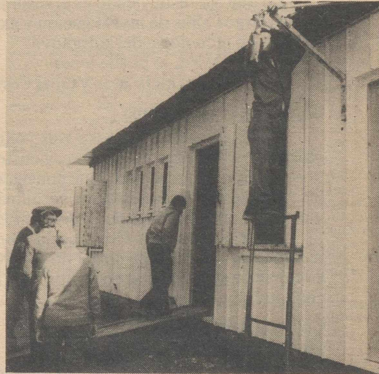
Construcción de la primera vivienda prefabricada de Alcalá del Júcar con destino a los afectados por la riada.
