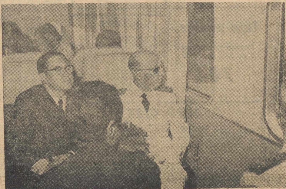
El Caudillo, con el ministro de Obras Públicas, en el interior del tren que inauguró la línea Madrid-Burgos. (Foto CIFRA).
