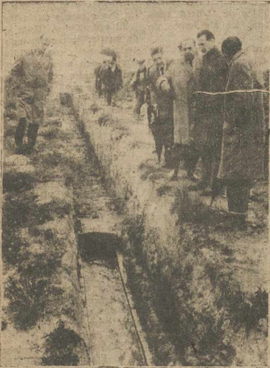
Las autoridades recorriendo las obras inauguradas en Cordovilla en la mañana de ayer.
