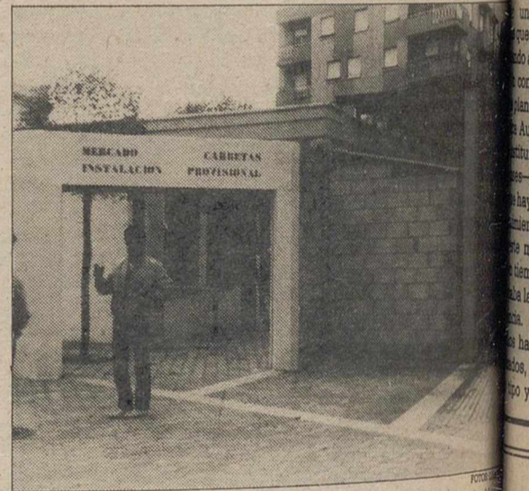
El mercado de Las Carretas continúa su remodelación.
