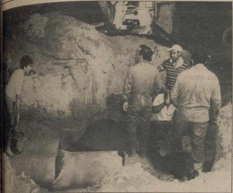
La proximidad de ambas tuberías provocó la contaminación de parte de la red
