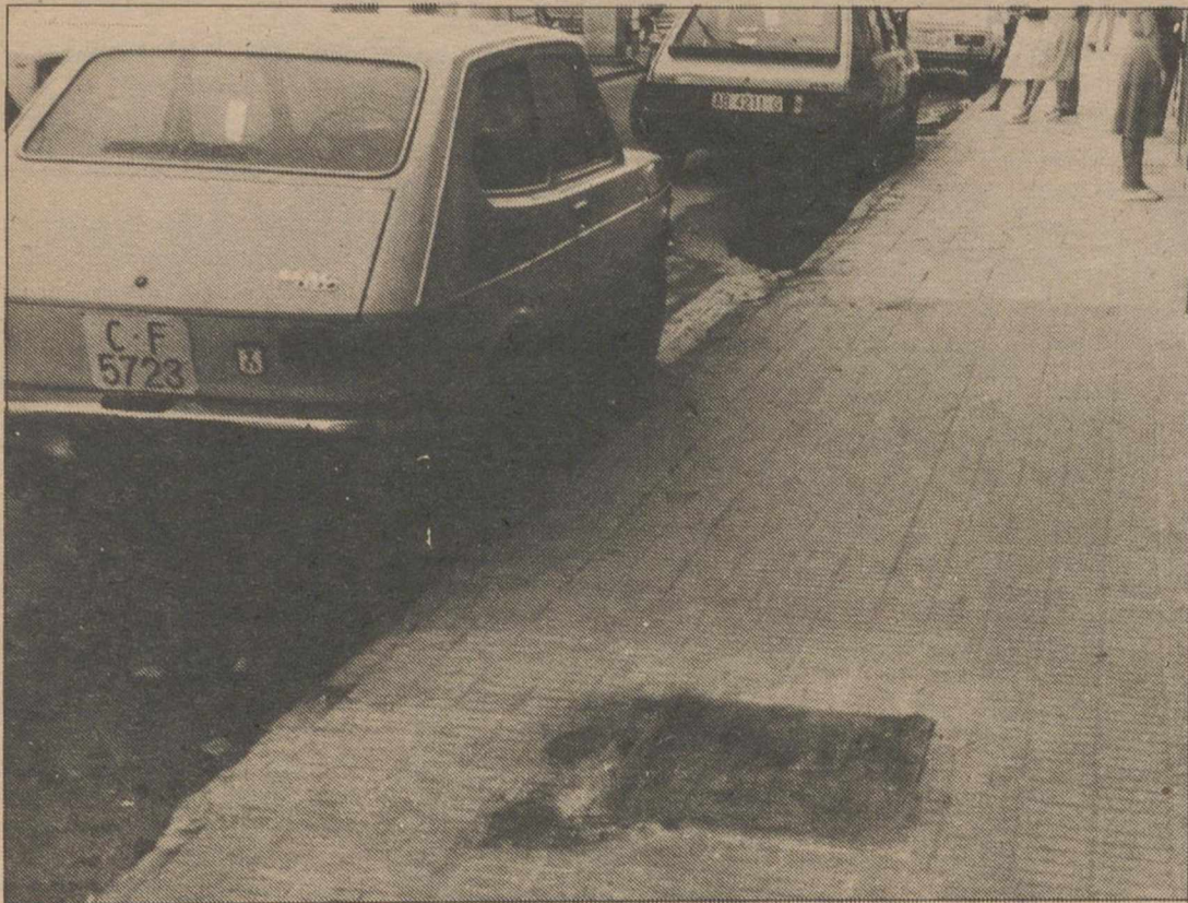
Por fin fue reparado el problema de los imbornales de la calle de la Feria FOTOS: LUIS MIGUEL
