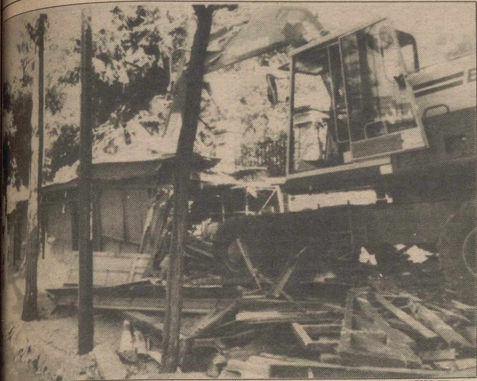
Derribo de las casetas de la Cuesta de Moyano en Madrid.
