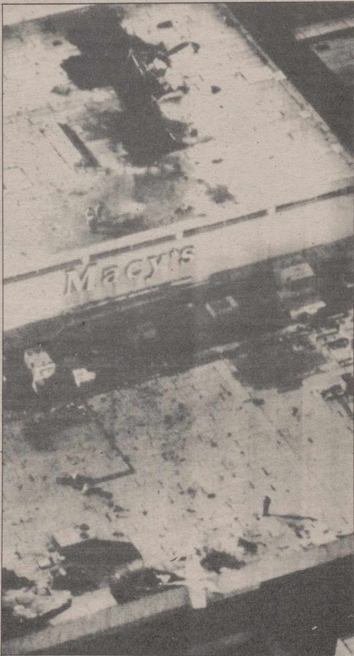
El avión se estrelló destrozando el edificio de los grandes almacenes.
