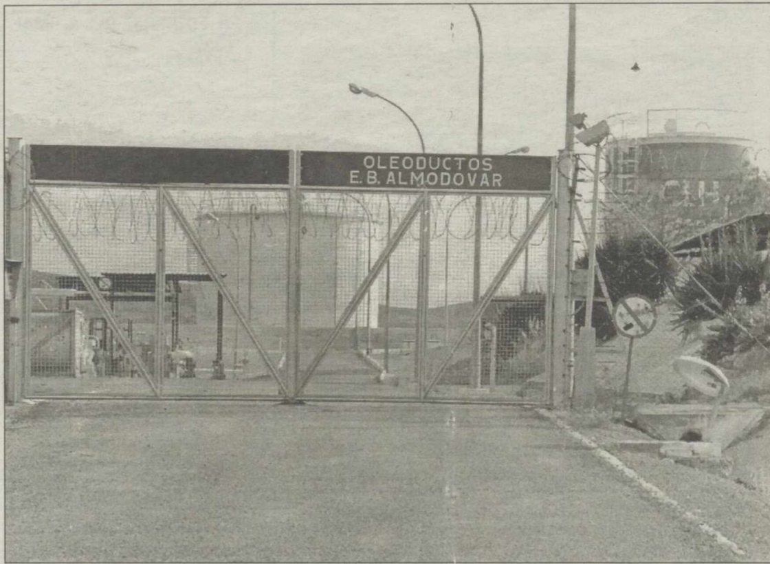
La estación de bombeo de CLH de Almodóvar del Campo
