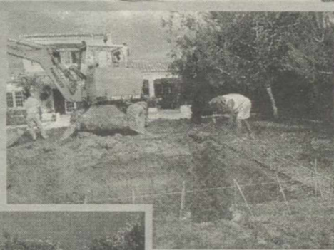
Malla de acero para formar un tanque sin juntas
