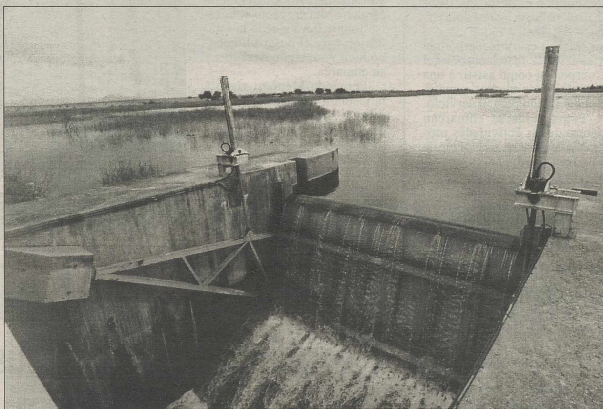
La recuperación del nivel de los acuíferos manchegos ha sido evidente en zonas como Las Tablas de Daimiel. RUEDA
