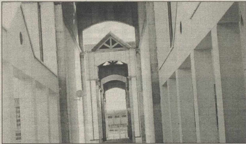
Uno de los cinco bloques de viviendas.
