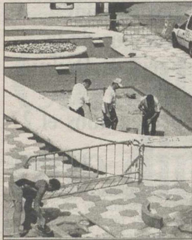
Las obras van a buen ritmo.
