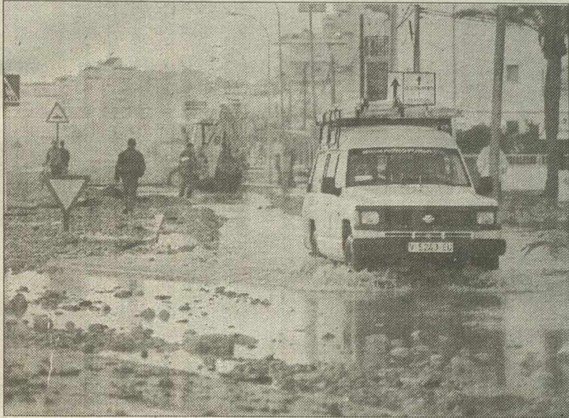
Estado de la carretera entre Benicarló y Peñíscola.
